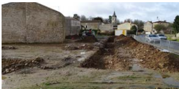
Le chantier de fouilles - janvier 2020
