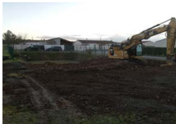
Agrandissement du bassin d'orage / lotissement de la Bachellerie
