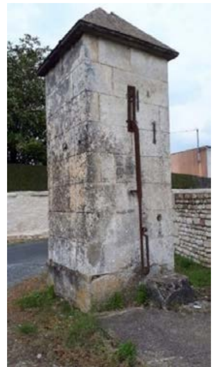
L'une des trois pompes de Villiers-en-Plaine
